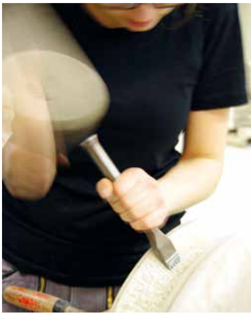
Bearbeitung einer Säulenbasis mit Zahneisen
