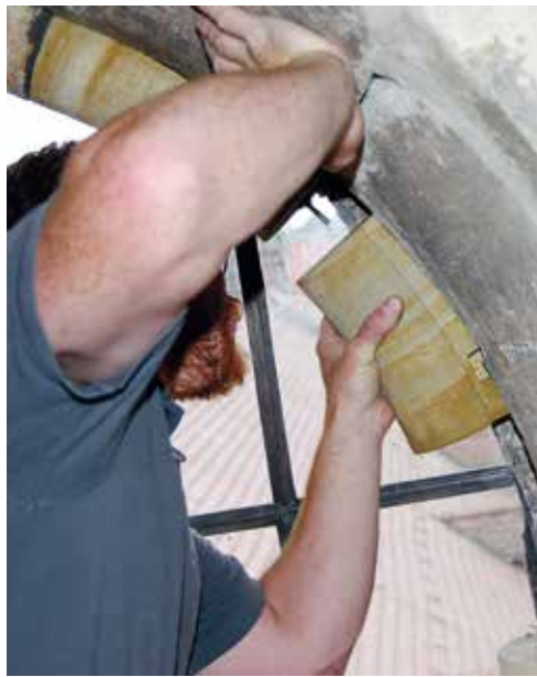
Versetzen eines Steins in einer Fensterlaibung
